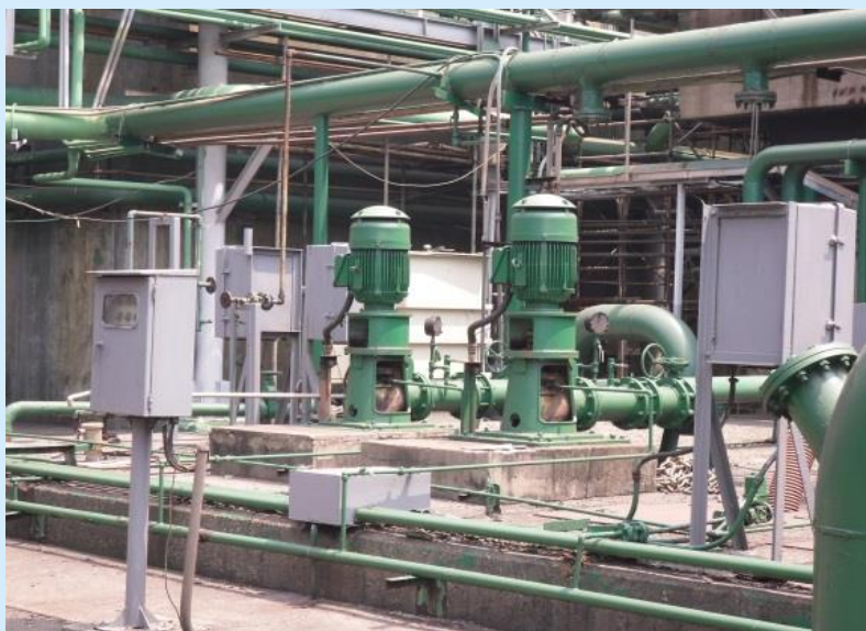
回收水井(2)及其設備
