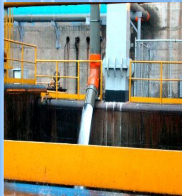
第一熱軋場屋頂雨水回收入鐵銹坑情況
